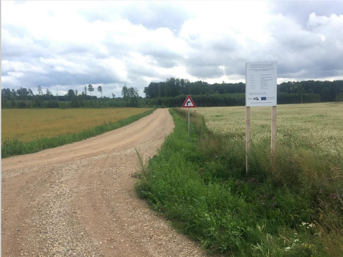
"Baltinavas novada pašvaldības grants ceļu pārbūve"
